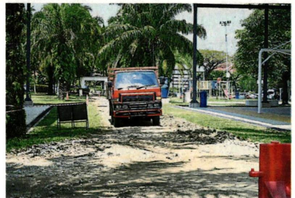
配合出入公园湖泊施工的重型车辆, 市政厅将从2个出入口的设水泥路面新路段, 以承担10吨重的罗里行驶。
